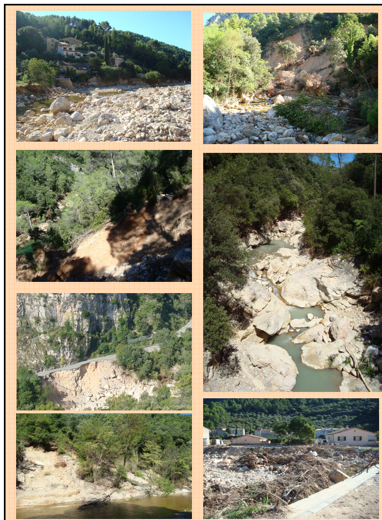
Graphique 9 : Photos prises après les inondations sur ou à proximité du site Natura 2000
